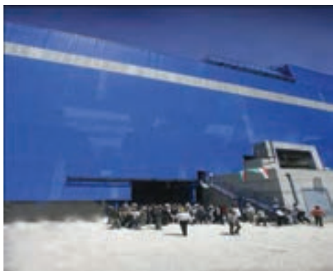
شکل ۱۸-۵- مجتمع فولاد ویان - کبودرآهنگ
