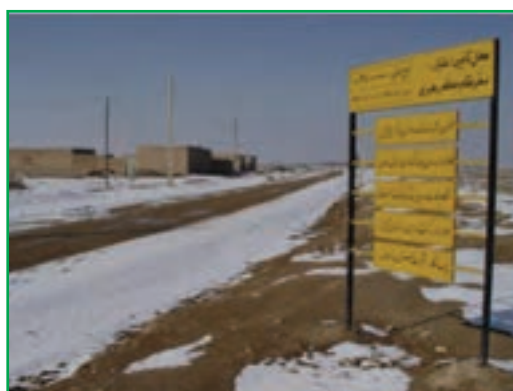
شکل ۶-۶- پروژه احداث راه روستایی - آق تپه
